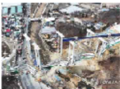
고속도로 교량 붕괴 (2.25.)
